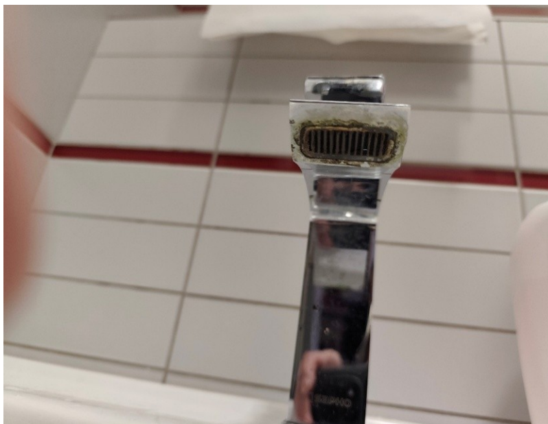
Údržba WC. Tato baterie má plochý perlátor. Tuto baterii nelze osadit šetřiči WATERSAVERS
